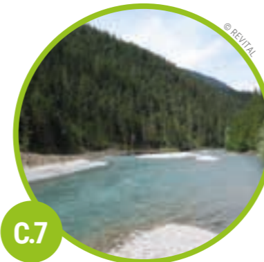
C.7 STOCKKACH Das breitere Flussbett bringt mehr Sicherheit bei Hochwasser und einen besseren Zugang zum Fluss. → Seite 10
