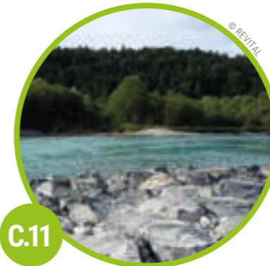
C.11 STAATSGRENZE BIS LECH-SCHLUCHT Ein Sporn aus Blocksteinen lenkt den Lech auf die deutsche Seite und bringt wieder Dynamik in die Au. → Seite 17
