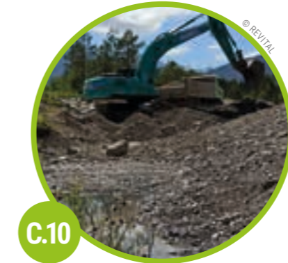
C.10 LECH FORCHACH Buhnen wurden gekürzt, ein Gerinne als „Koppenbach“ reaktiviert, der Flussraum zur „Dynamisierung“ freigegeben. → Seite 16
