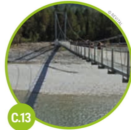
C.13 FORCHACH HÄNGEBRÜCKE Die Engstelle ist beseitigt! Für Besucher ein idealer Ort, den Wildfluss von der neuen Brücke aus hautnah zu erleben. → Seite 14
