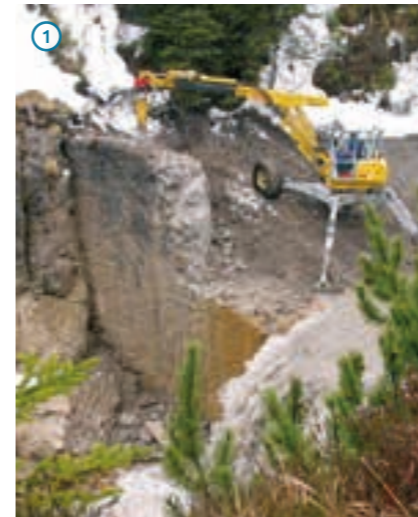
Abtrag der Hornbach-Sperre im Zuge des 1. LIFE-Projekts am Tiroler Lech 2001-2007
